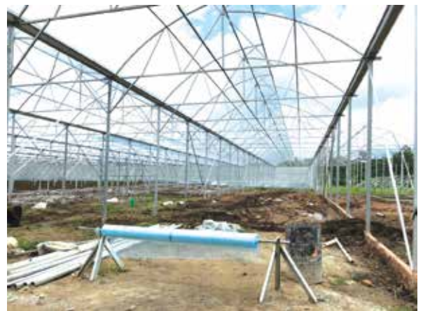
Xây dựng nhà kính tại xã Phi Liêng
